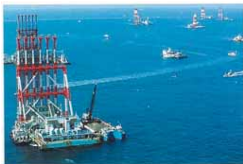
大型サンドドレーン船による地盤改良
